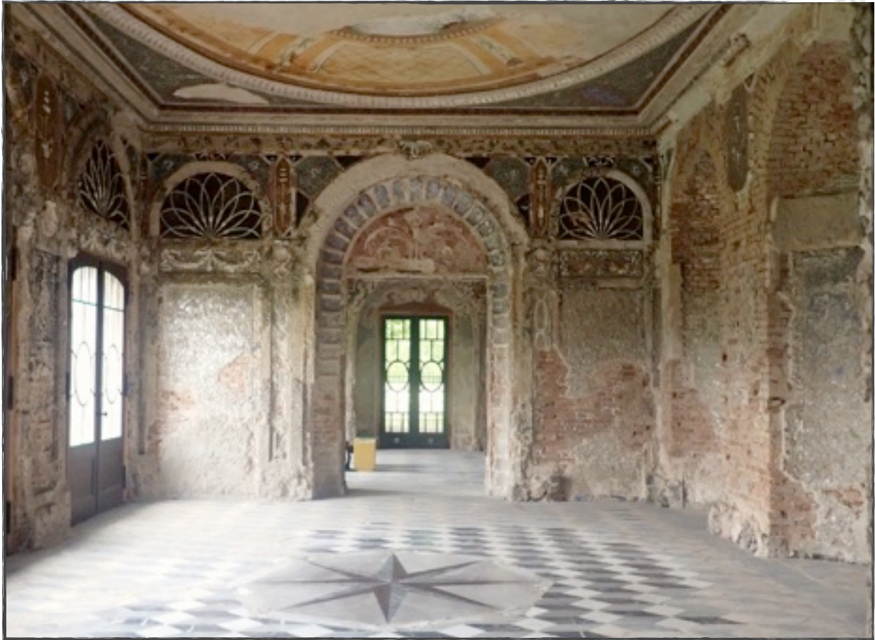
„Restaurierter Marmorfußboden im mittleren Saal“ Danke an Lutz Schummel für das Foto (Ausschnitt, Juni 2024)
